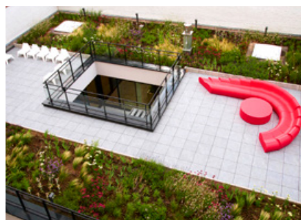
Kantoorgebouw Brand Whitlock 87 – Brussel Gedecentraliseerd (BE)
