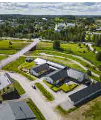
► Woonzorgcentrum - Sipoo (FI)
